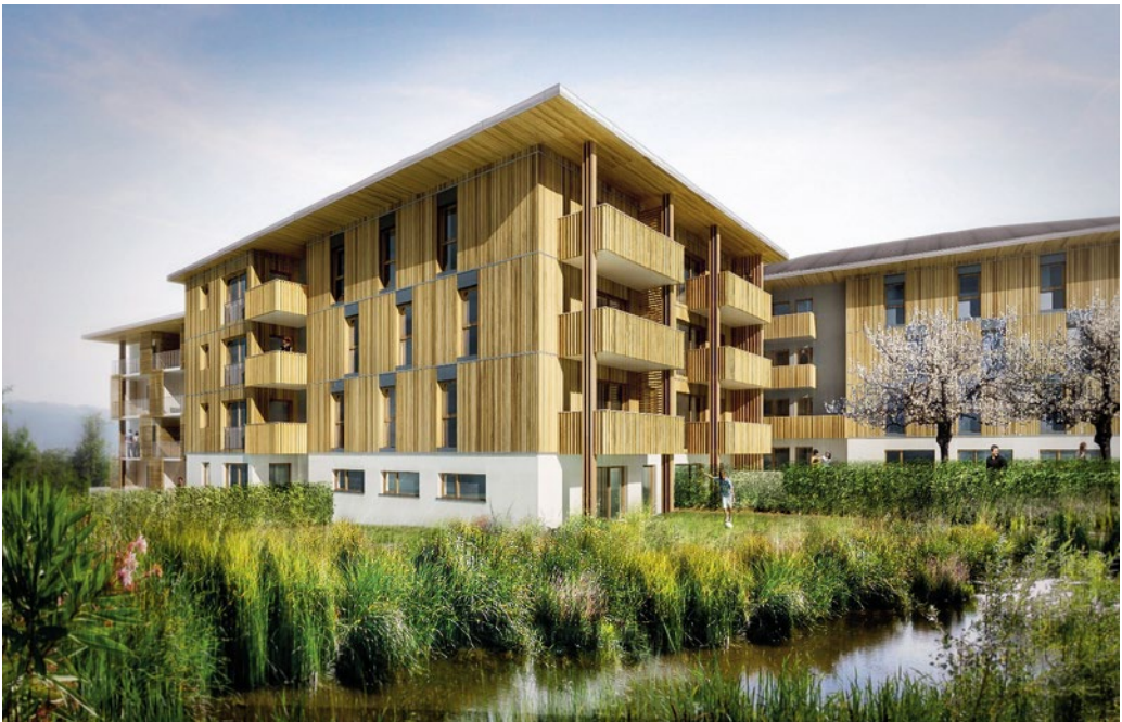
Source : chassagne + delétraz architecture.
