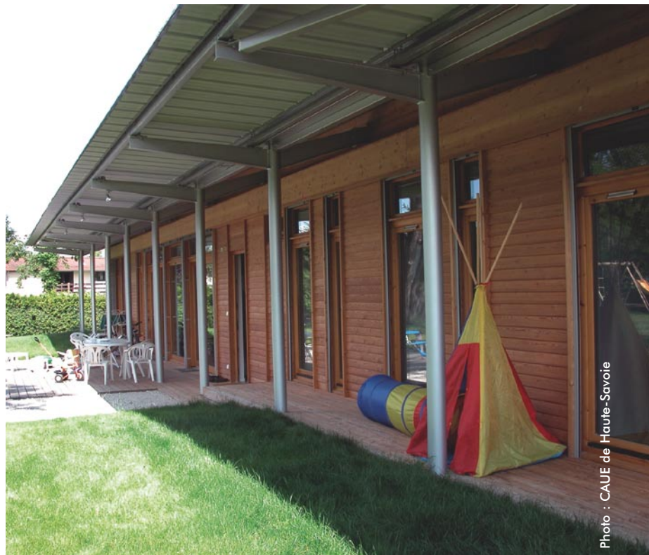
↑ À Ayzé, en Savoie, cette maison en bois reprend un détail constructif emprunté à la maison des Bauges. D'une part, une toiture en pente douce qui retient la neige l'hiver, d'autre part, un prolongement généreux pour abriter la terrasse des intempéries et du rayonnement direct du soleil en été.
