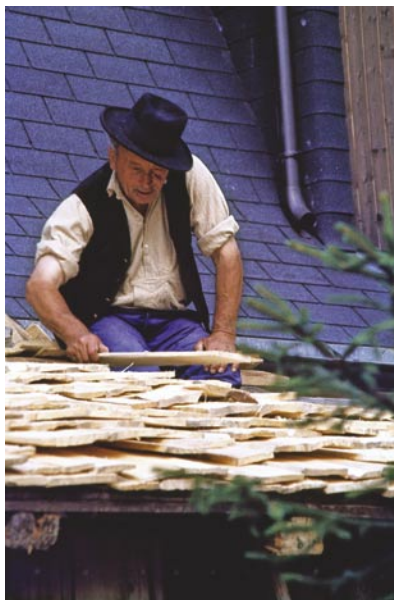
↑ La couverture en tavillons, tuiles de bois, est une technique ancestrale que l'on voit réapparaître aujourd'hui.
