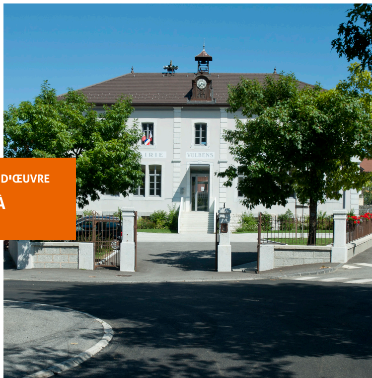
Mairie de Vulbens, C. Boidevaix, architecte © CAUE 74 / Béatrice Cafiéri
