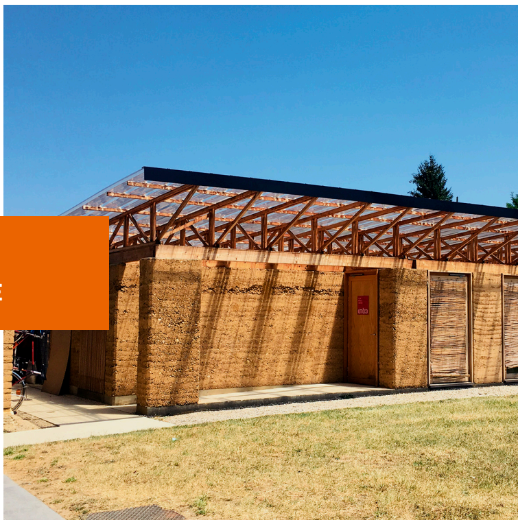
Expérimentation construction en terre, Les Grands Ateliers de L'Isle-d'Abeau © CAUE 74
