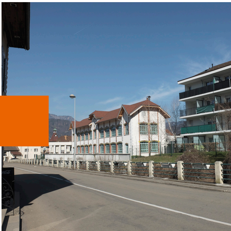
Réhabilitation de l'usine AlpeX, Scionzier, Atelier Archiplein © CAUE 74 / Béatrice Caféri
