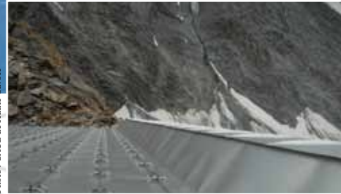
Photo: CAUE de Haute-Savoie
