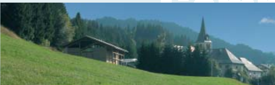
Chaufferie bois des Gets
